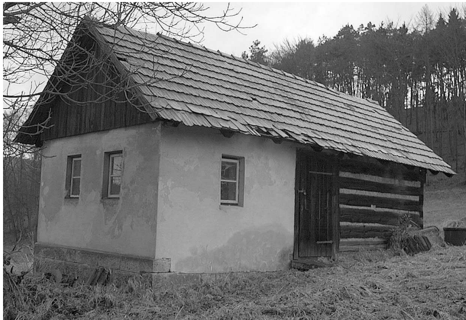
“Havlíkova” sušárna. Pohled na vyzděnou přípravnu. Pravá část objektu je roubená a sloužila jako sušičí komora. Stav k 12. 2. 2002. Foto archiv autora.
